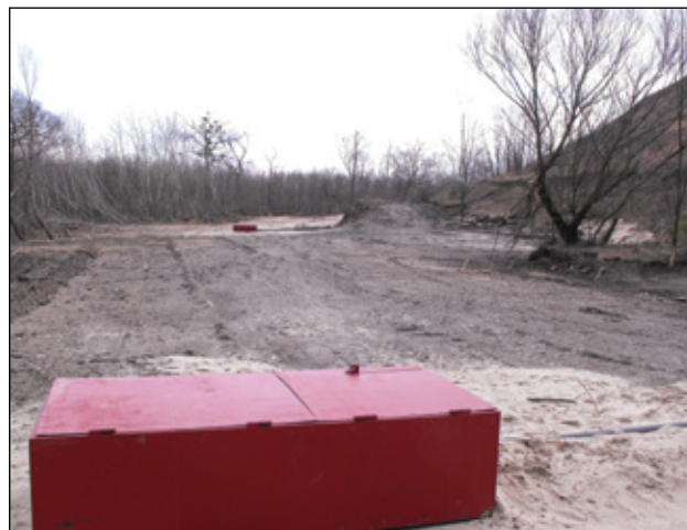
Bányhidai Erőmű – zagyter mélyszivárgó rendszer aknakútjai
